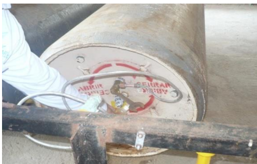
Instalación de Tanques de Cloro-Mtto?
