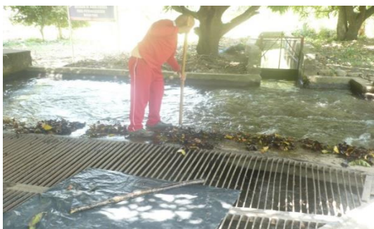
Limpeza de rejillas en Bocatoma Y PTAR
