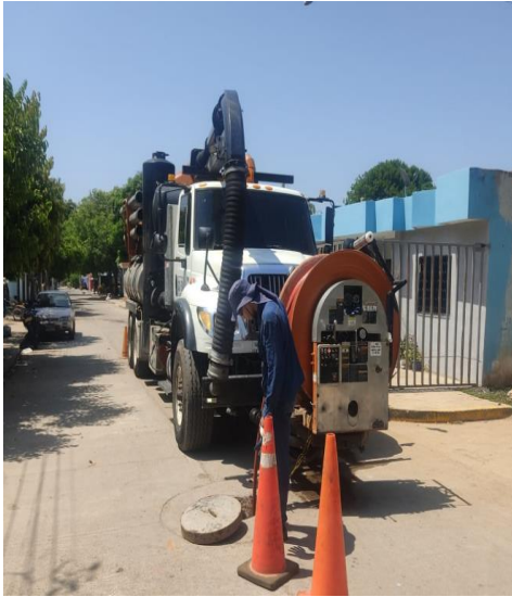
Evidencia labores de mantenimiento en sistema de alcantarillado sanitario con equipo hidrosuctionador
