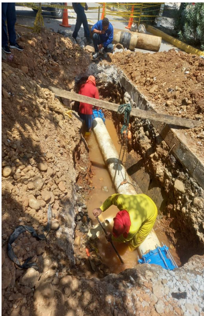
Evidencia labores de mantenimiento en sistema de acueducto.
