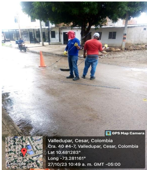
Evidencia labores de mantenimiento en sistema de alcantarillado sanitario con equipo hidrosuctionador
