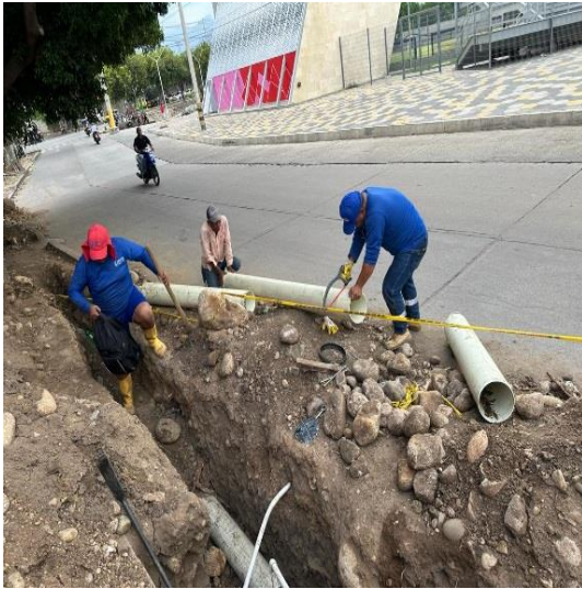
Evidencia instalación de tubería de acueducto en carrera 31 con calle 16 C.
