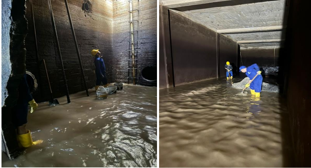
Evidencia mantenimiento tanque 2.000 m3 - PTAP
