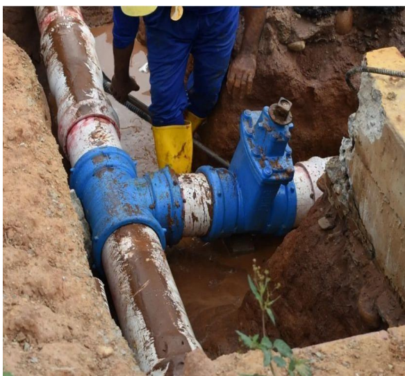
Evidencia labores de mantenimiento en sistema de acueducto.
