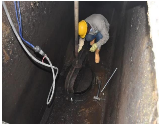
Evidencia mantenimiento válvulas filtros – PTAP LA HUARICHA
