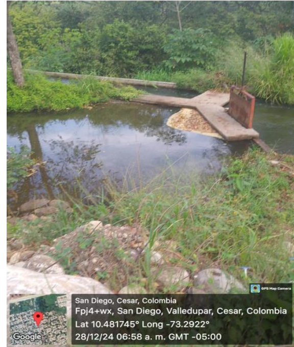
Evidencia Extracción de material y ampliación del vaso donde confluyen los canales, elevado y solución
