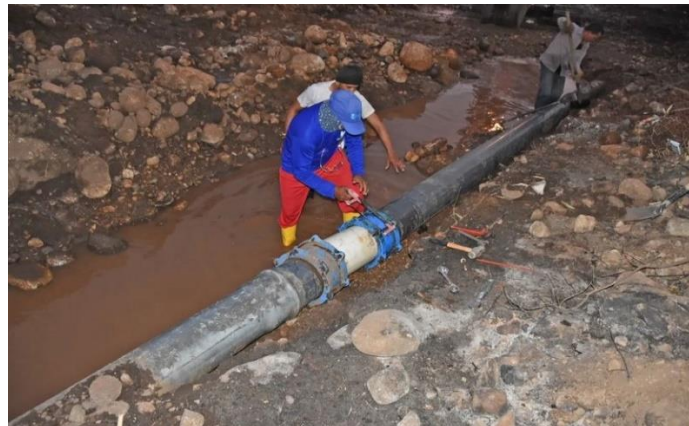
Evidencia apoyo en reparación de tubería Urbanización Altos de Comfancesar
