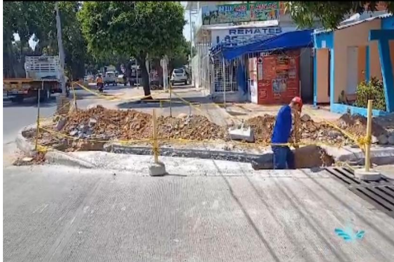
Evidencia Optimización sistema de Acueducto Carrera 32, B. Primero de Mayo
