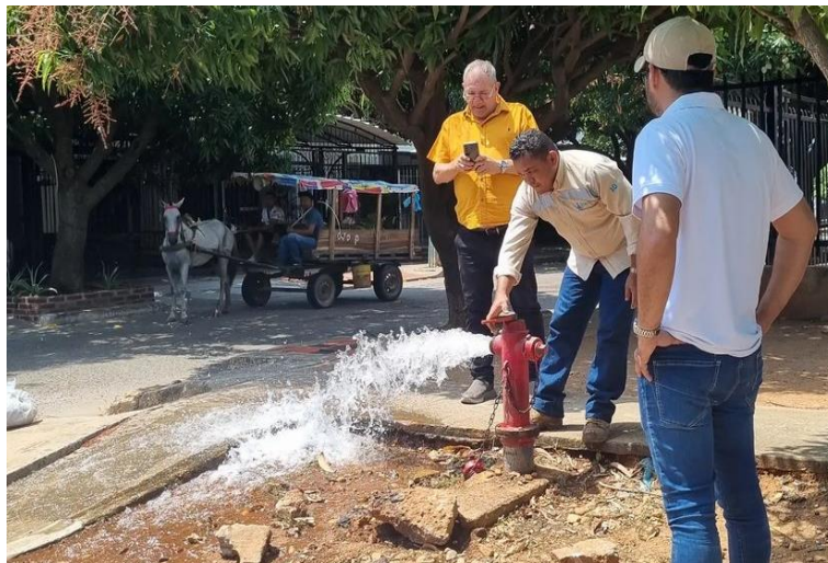
Evidencia Optimización sistema de Acueducto Urbanización Don Alberto
