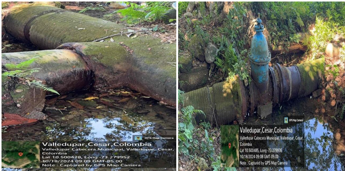
Evidencia ANTES de recuperación de fugas en válvulas del tanque La Pedregosa
