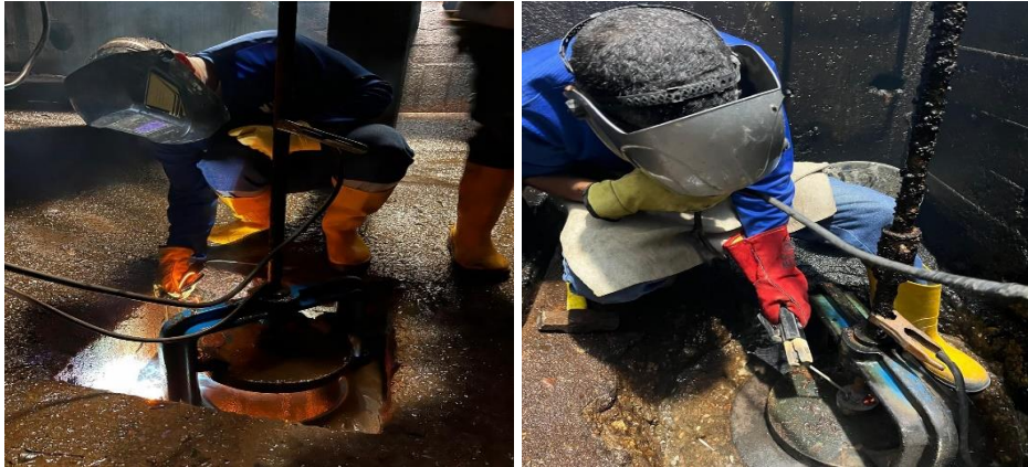
Evidencia reparación y mantenimiento en general válvulas de lavado y purga de sedimentadores y floculadores PTAP Huaricha
