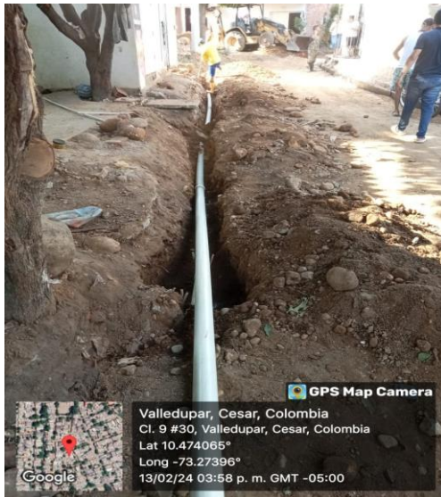
Evidencia instalación de tubería de acueducto en carrera 30 A entre calles 8 A y 8B – Barrio 5 de enero.
