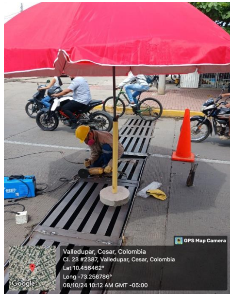
Mantenimiento de rejillas en sumidero transversal del sistema de alcantarillado pluvial de la ciudad de Valledupar
