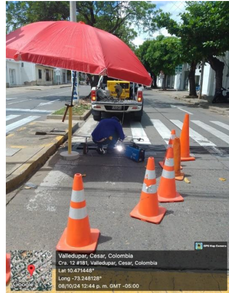
Mantenimiento de rejillas en sumidero transversal del sistema de alcantarillado pluvial de la ciudad de Valledupar
