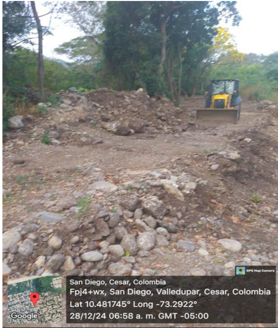
Evidencia Extracción de material y ampliación del vaso donde confluyen los canales, elevado y solución
