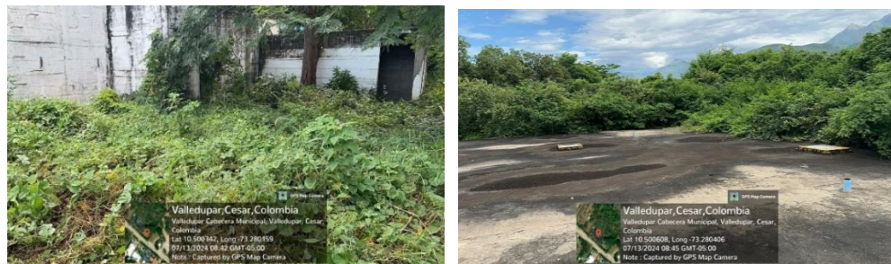
Antes de las labores de Limpieza
