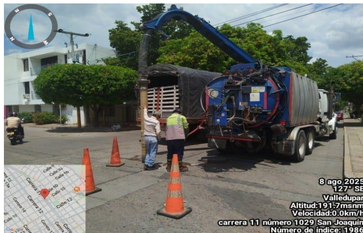
Imagen. Evidencia Mantenimiento con Equipo Hidrosuccionador
