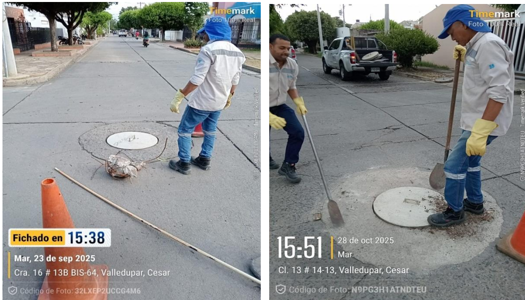
Imagen. Evidencia Reposición tapas pozos de inspección.
