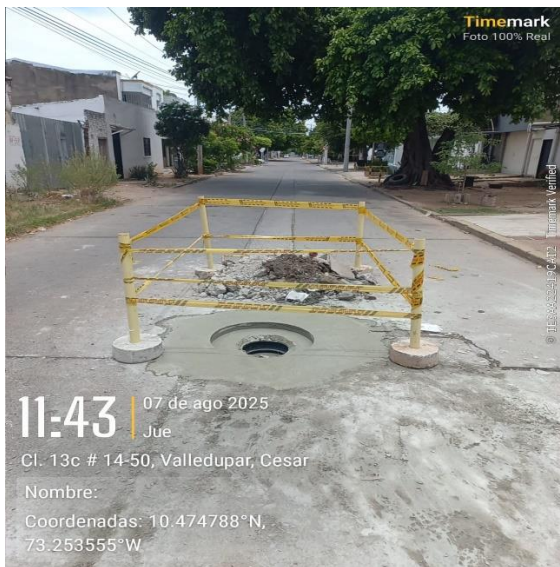
Imágenes de evidencia de Construcción Placa superior pozo de inspección
