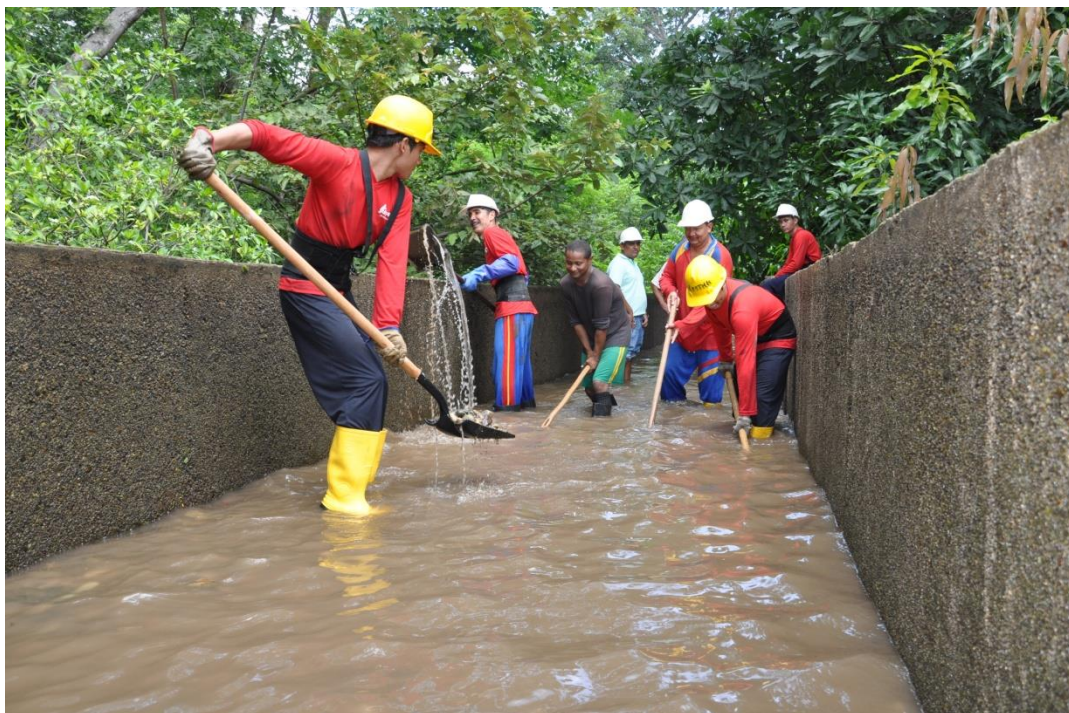
Imagen 17. Mantenimiento del canal de aducción
