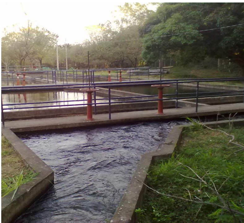
Imagen 11. Desarenador
